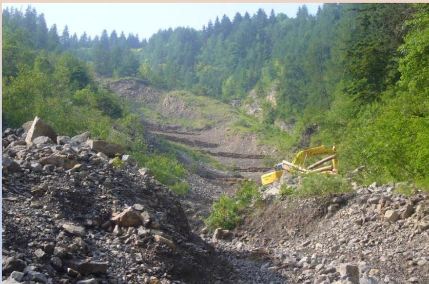
RISEZIONAMENTO ALVEO del torrente con ASPORTAZIONE DI MASSE DETRITICHE per 9.170 mc.
